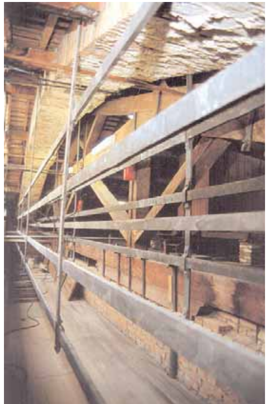
Figura 6 - Um dos dois arcos de alvenaria da cobertura com 20 metros de vão livre, atirantados por tiras metálicas; arrojado de engenharia no final do século XIX.
