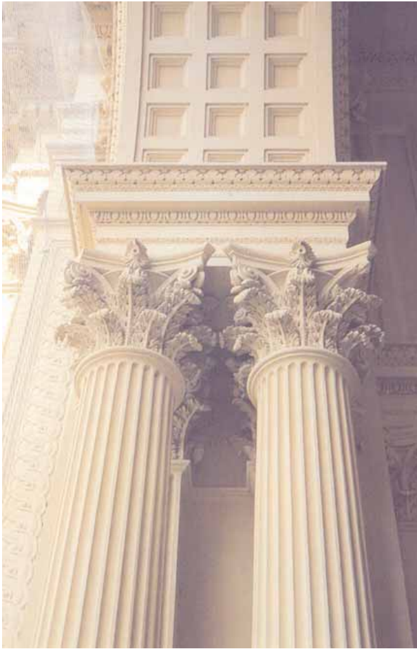
Figura 9 - Detalhe da fachada, arcadas segundo ordem coríntia
