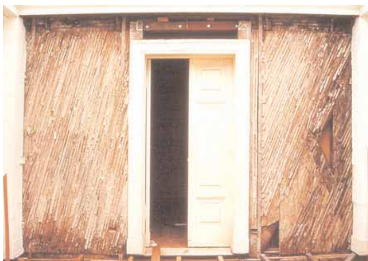
Figura 4 - Parede de Tabique
