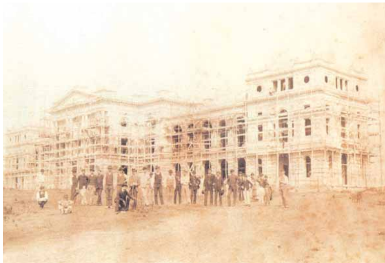
Figura 16 - conjunto comemorativo da inauguração das obras do edifício em 25 de março de 1885, data comemorativa da outorga da Constituição do Império
