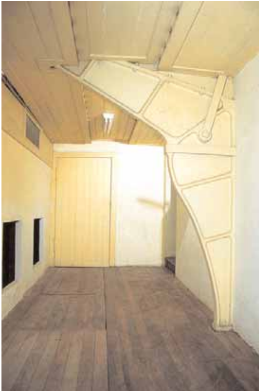
Figura 5 - Balanço interno do pórtico de aço fundido em cuja extremidade fica apoiada a treliça metálica da cobertura de vidro.
